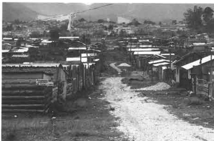
Photo 3 - Nord du Fraccionamiento Primero de Enero.
