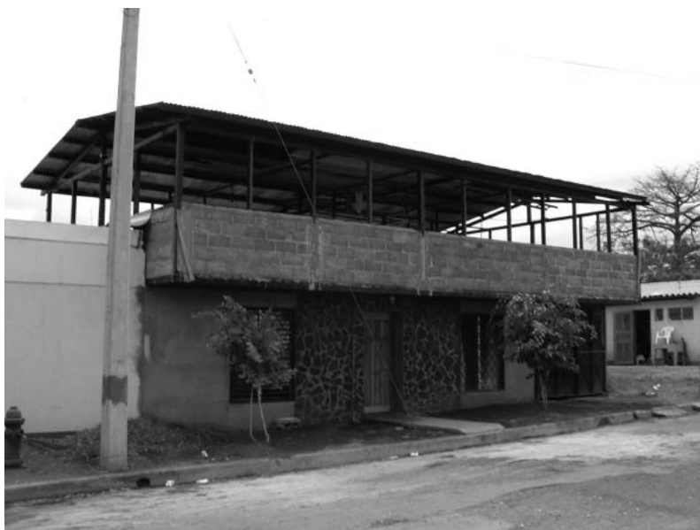
Figura - 3 Inmueble construido dentro del marco de un programa financiado por la Unión Europea según normas parasísmicas en el barrio de San Sebastián en el 2000. Un año más tarde, el propietario del inmueble ya había emprendido de manera completamente ilegal trabajos de ampliación, lo que hacía a su vivienda muy peligrosa en caso de sismo (Foto: S. Hardy 2001).
