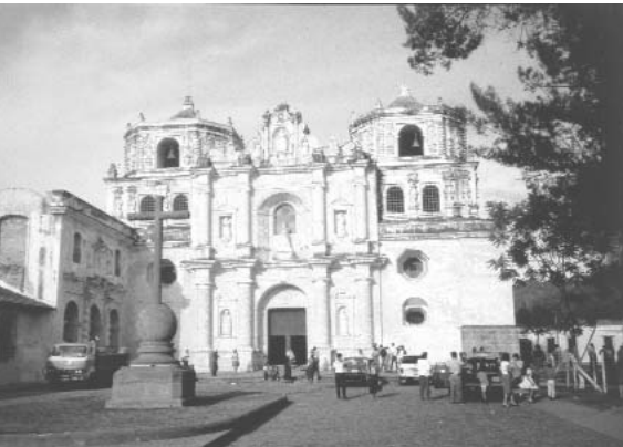
Figura 4 – Iglesia del convento de la Merced, Antigua Guatemala (foto de Alain Musset).
